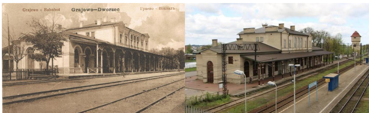
Budynek zabytkowego Dworca kolejowego w Grajewie
